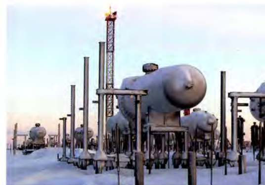
УКПГ-1 Бованенковского НГКМ
