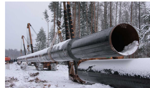
Строительство магистрального газопровода
