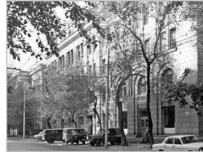
Фасад первого корпуса института «ВНИПИгаздобыча». 1980-е годы
